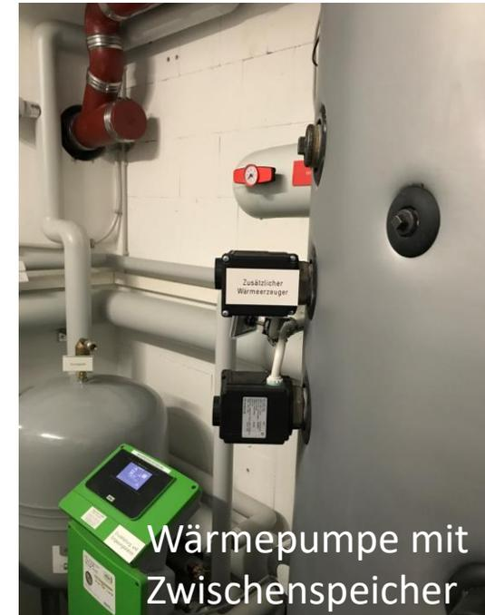
Wärmepumpe mit Zwischenspeicher
